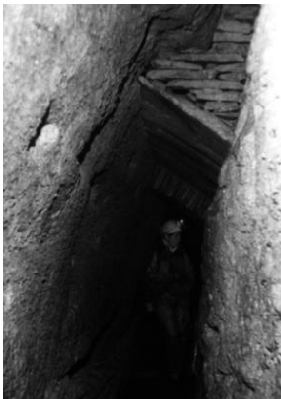
Abbildung 106: Ausbau mit Steinplatten Foto: privat
