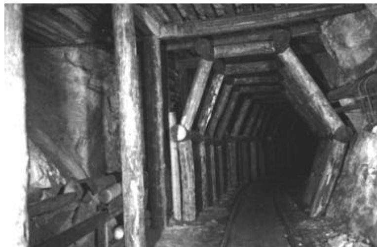
Abbildung 98: Ausgeführter Polygonausbau Reproduktion aus: [48]
