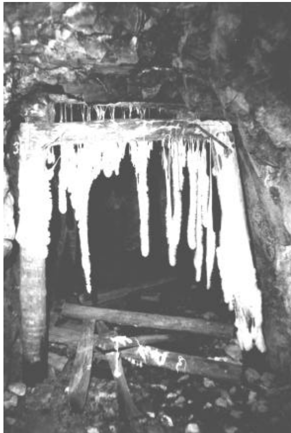
Abbildung 42: Pilzmyzelbehänge an einem Türstock
