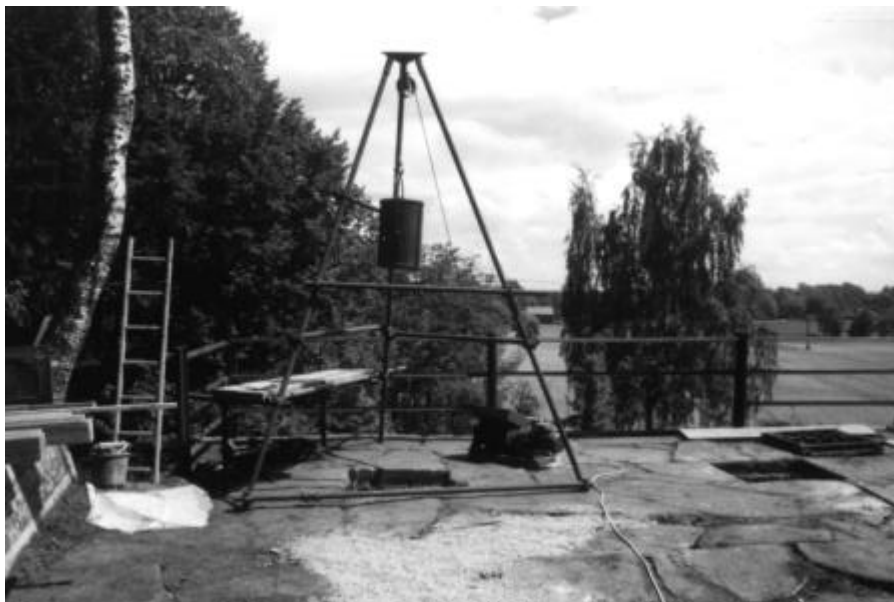
Abbildung 83: Baustelleneinrichtung einer weniger aufwendigen Schachtbaustelle
