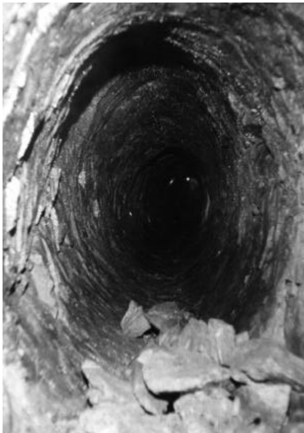
Abbildung 64: Feuergesetzte Strecke
