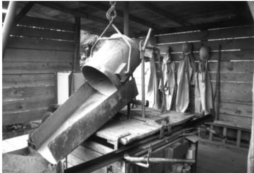
Abbildung 79: Entleeren von Förderkübeln II Kippgestell
