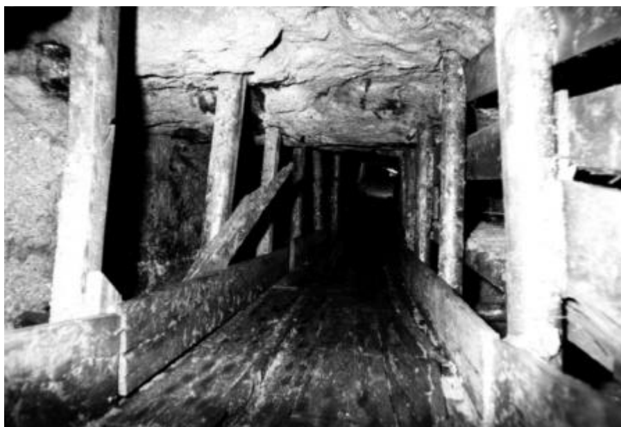
Abbildung 82: Tonnbretter und Vertonnung
