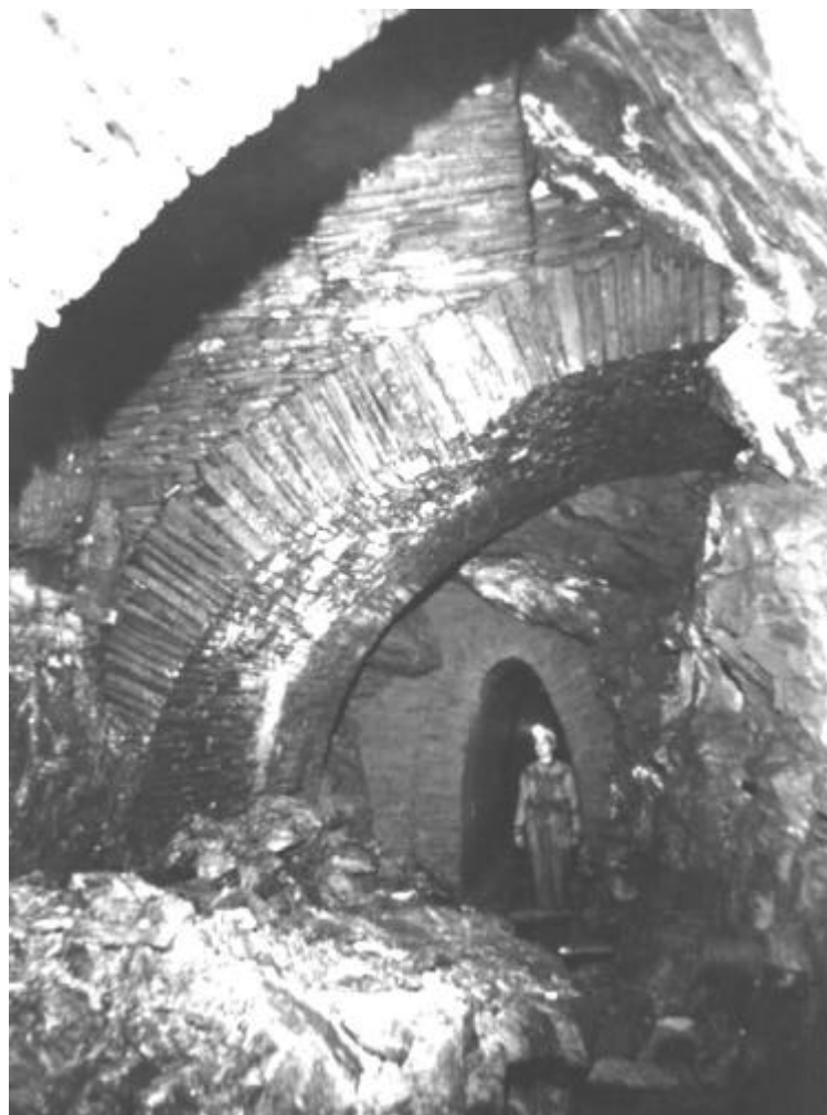
Abbildung 100: Trocken gesetztes Gewölbe mit überspringenden Bögen
