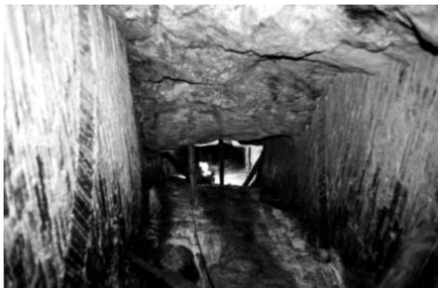
Abbildung 112: Schachtmauerung als Scheibenmauern Foto: privat Blick von unten nach oben im tonnlägigen Schacht mit Blick zum Liegenden. Der Schacht ist im Gang aufgefahren und links und rechts mit Scheibenmauern vom Gang bzw. Abbau getrennt, Hangendes und Liegendes werden durch das Anstehende ohne Ausbau gebildet
