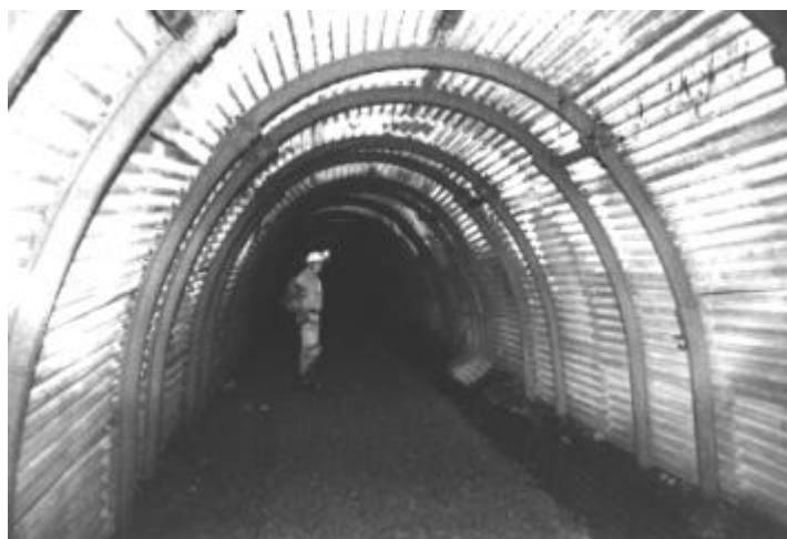
Abbildung 99: Ausbau mit Stahl
