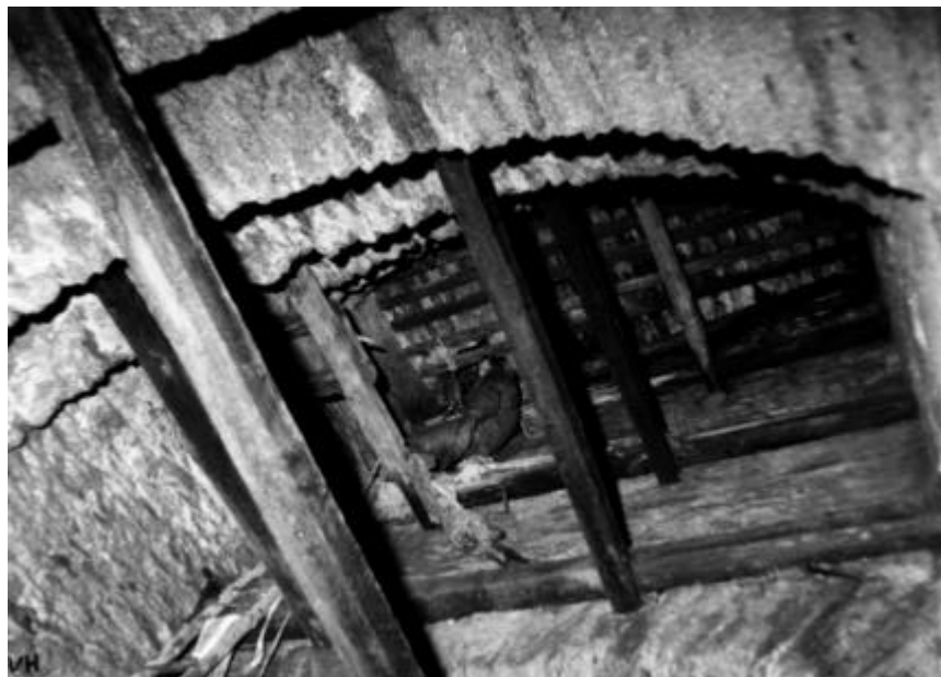
Abbildung 111: Schachtmauerung mit überspringenden Bögen Foto: privat Blick von unten nach oben im tonnlägigen Schacht mit Blick zum Liegenden
